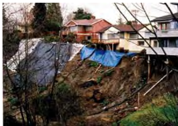
OBR. 68: Zosuvy pôdy v severozápadnej časti mesta Seattle; ZDROJ: [306]
