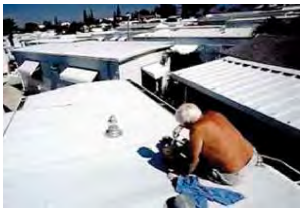
OBR. 40: Ukážka aplikácie bielej odrazivej strechy; ZDROJ: [224]
