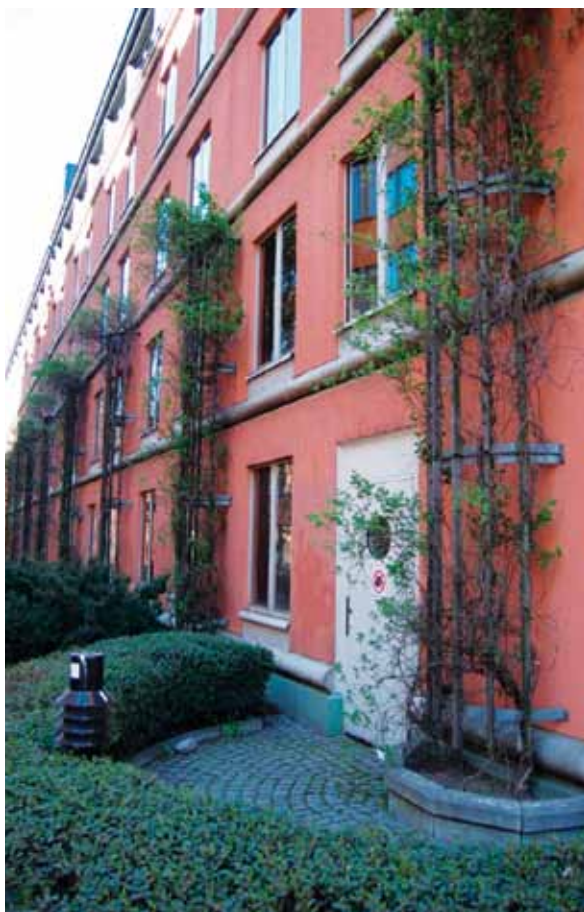
OBR. 47: Popínavé a ovijavé dreviny na fasádach ZDROJ: foto autora, Ing. Zuzana Hudeková
