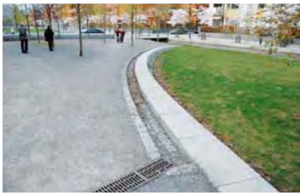
OBR. 51: Dažďová voda za pomoci podzemného a otvoreného systému odvádzania sa vlieva o umelo vytvoreného vodného kanálu ZDROJ: archív autora, Ing. Zuzana Hudeková
