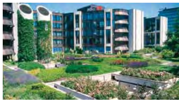
OBR. 73: Zelená strecha banky United Bank of Switzerland, Bazilej s vekom vegetácie cca 8 rokov; ZDROJ: [283]
