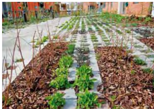
OBR. 46: Zaujímavo riešený povrch zabezpečujúci priepustnosť; ZDROJ: archív autora, Ing. Zuzana Hudeková
