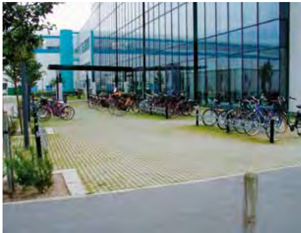
OBR. 45: Zabezpečenie priepustnosti povrchu za pomoci zatrávňovacej dlažby
