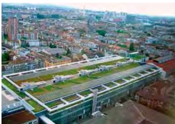
OBR. 71: Zelená strecha hlavnej výstavnej siene v meste Bazilej je najväčšou vo Švajčiarsku (16 000 m 2 ) a pokrývajú ju fotovoltaické články, ktoré produkujú 215 000 kWh/rok a ich účinnosť je zlepšená chladiacim efektom strešnej vegetácie; ZDROJ: [283]
