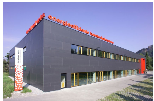
Obrázok 6: Administratívna budova po rekonštrukcii. Zdroj: Drexel und Weiss
