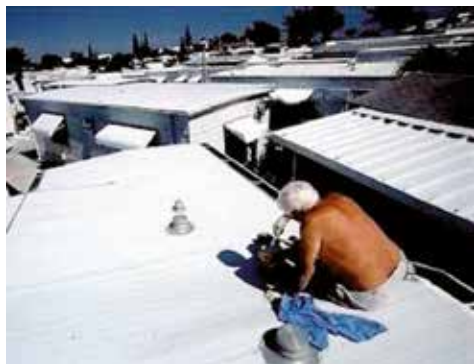
OBR. 20: Odrazivý povrch strechy
