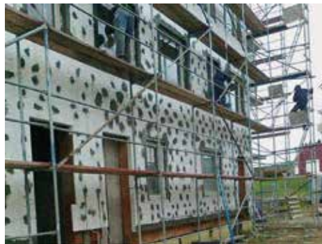
OBR. 17: Zatepľovanie budovy ZDROJ: http://www.comtel-sro.sk/stavebna-cinnost/realizac-na-cinnost/zateplovanie/
