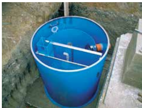
OBR. 22: Domová čistiareň odpadových vôd
