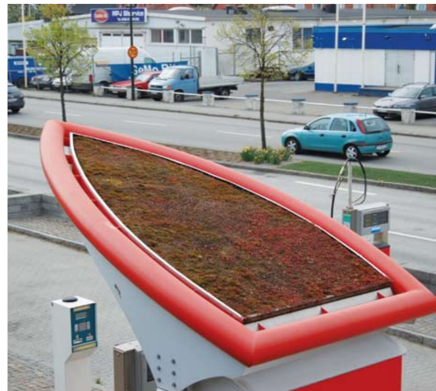
Extenzívna vegetačná strecha z rozchodníkov zadrží minimálne 50 % zrážok Foto: Z. Hudeková
